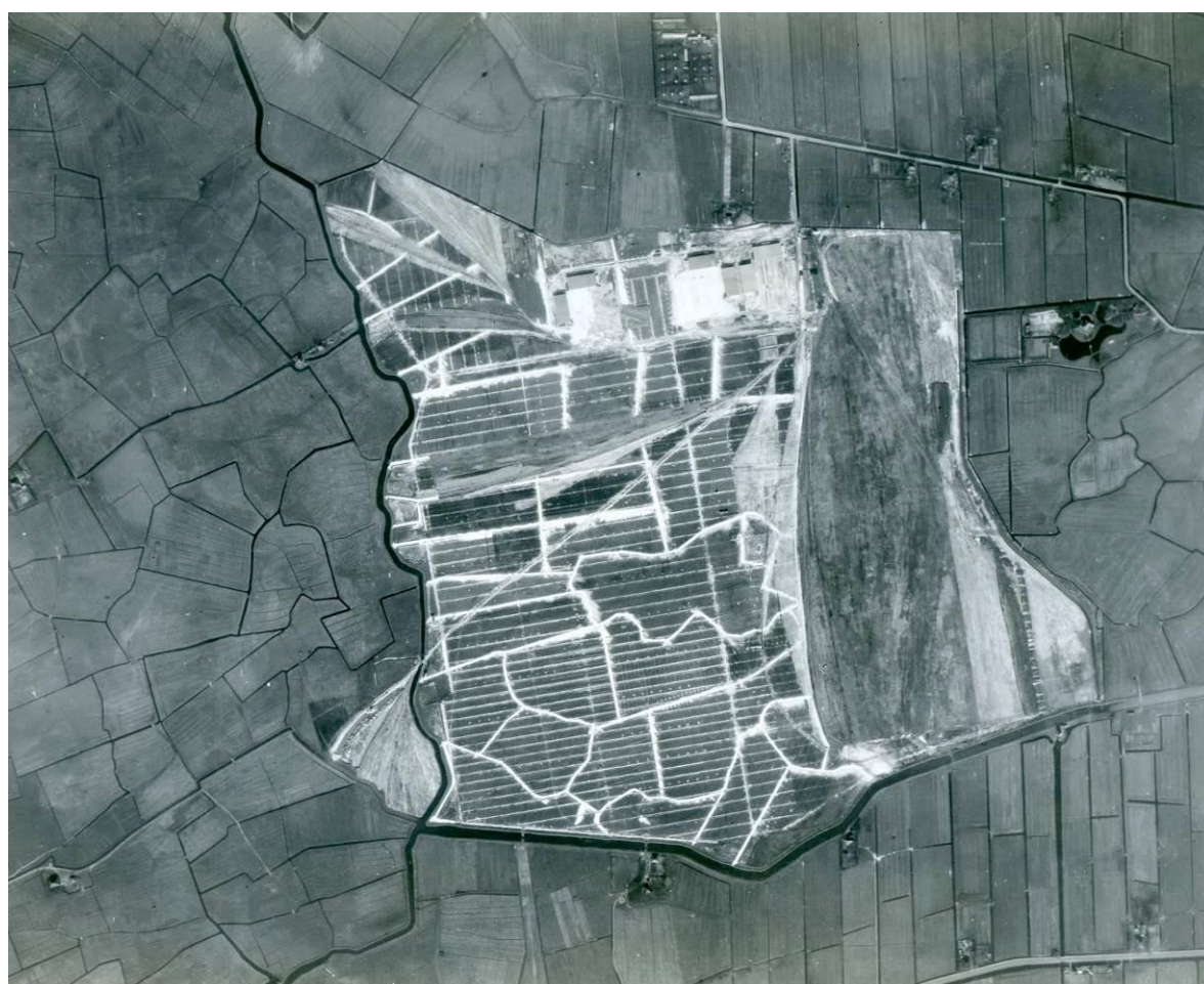
1938 Aanleg vliegveld. De witte strepen zijn met zand gedempte sloten
